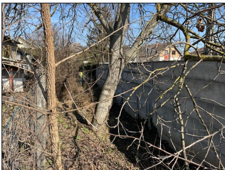
8. ábra: A leendő járda területe (helyszíni fotó)
