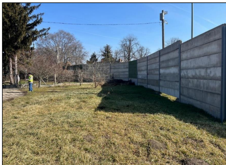
6. ábra: A leendő járda területe (helyszíni fotó)
